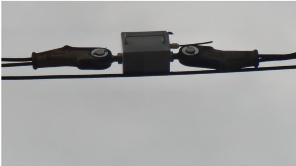
Рисунок 4.3 – Датчик-преобразователь нагрузки на проводах контактной сети
